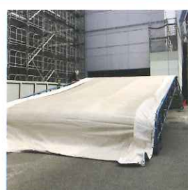
屋根フレームへの テントシート取り付け
