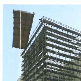
屋根の据え付け
